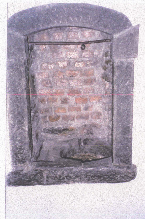
VANO SEME; BOCCA DEL POZZO
